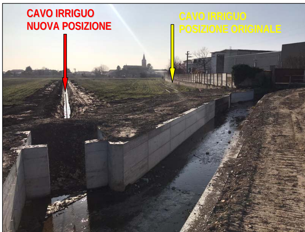
Fig. 3 – Lavori di traslazione del cavo irriguo interessante la proprietà Baruffaldi S.r.l.
